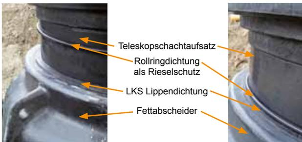
Teleskopschachtaufbau in Behälteröffnung einschieben
