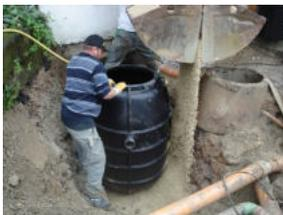
4.) Fettabscheider schrittweise abwechselnd
