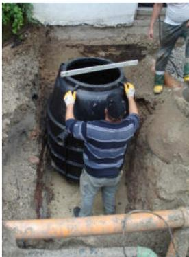
3.) Fettabscheider ausrichten
