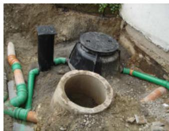
6.) Abwasserrohr wasserdicht anschließen
