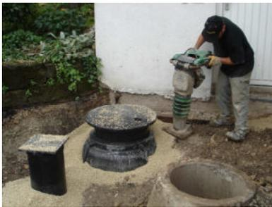
11.) ...Grube Verfüllen und Verdichten
