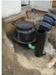
5.) Probenahmeschacht setzen
